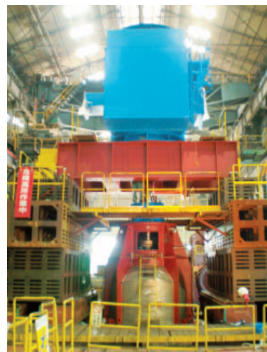
◇ポンプ（工場）据付状況外観
