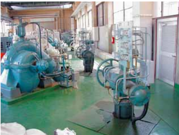
図13 油圧シリンダ (ポンプ室)
