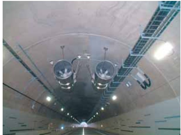
図12 口径1,250mmジェットファン
