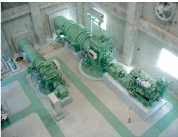
図1 幡谷排水機場
