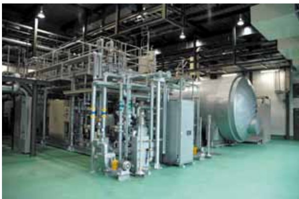
図1 300kW級 溶融炭酸塩形燃料電池全景 出典：「Tech-On!」( http://tecno.nikkeibp.co.jp ) 2005年3月11日のニュース
