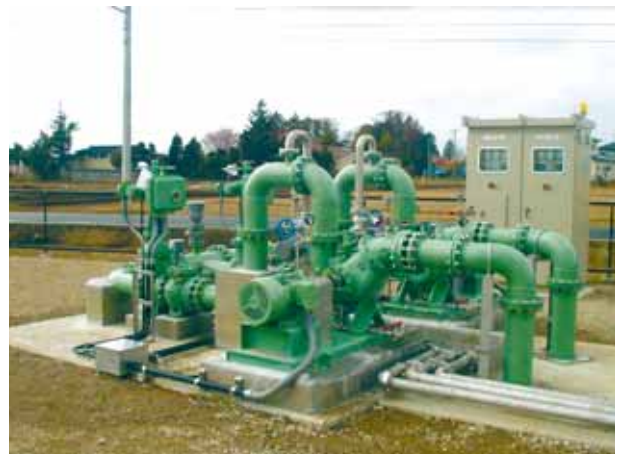
図2 田尻中央地区第12揚水機場
