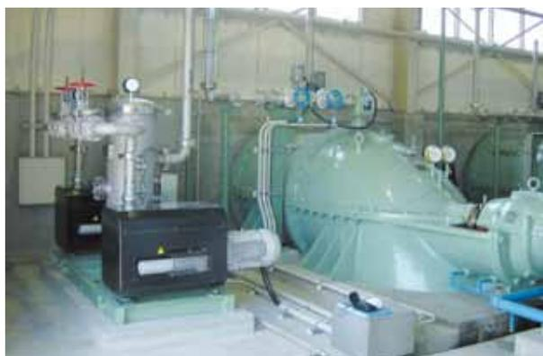
図3 寒水川排水機場の乾式満水ユニット (アントリア)
