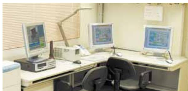
図5 安那排水機場に採用したWEBによる監視操作システム
