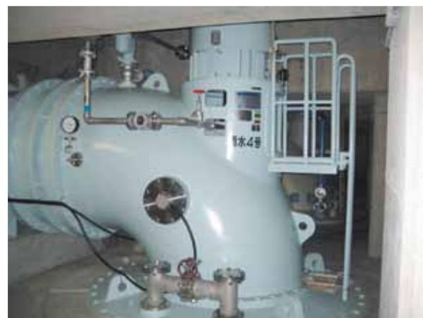
図6 神嶽ポンプ場に設置したポンプ流量計(デルタ400)
