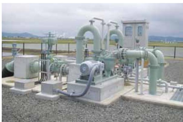
図4 田尻中央第12揚水機場の自吸式両吸込渦巻ポンプ(ホキレス)
