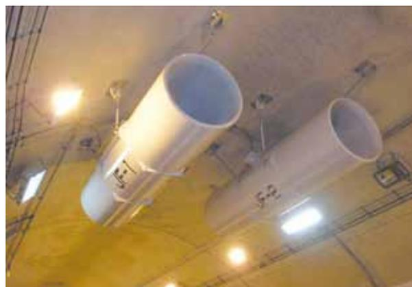
図7 口径1 030mm高風速型のジェットファンの外観 (弓張トンネル)
