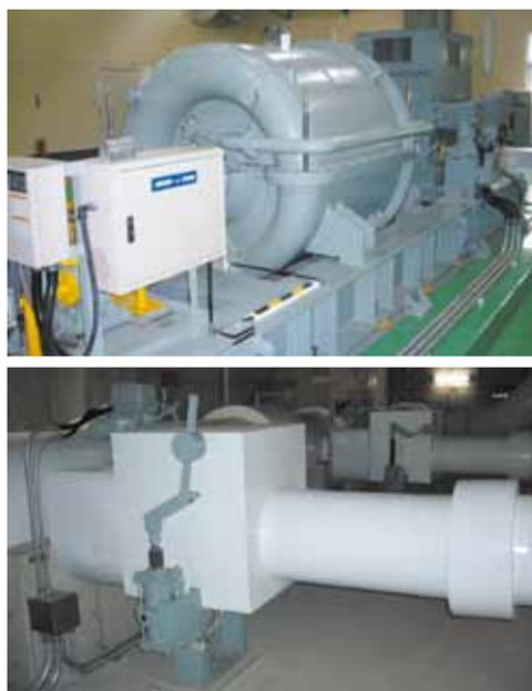
図9 ミストセパレータシステム（MSS-α）とエア・アシスト型逆止弁の設置例（横浜市環境創造部北部第二水再生センター）
