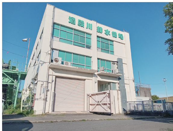
図3 機場外観と防水扉
