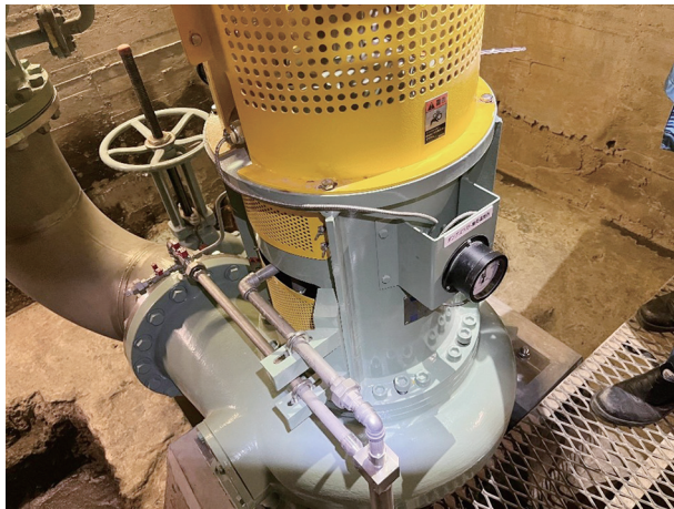
図6 立軸斜流ポンプ
