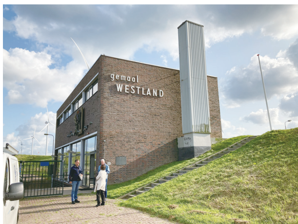
図9 ウェストランドポンプ場外観
