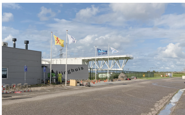
図7 防潮水門外観
