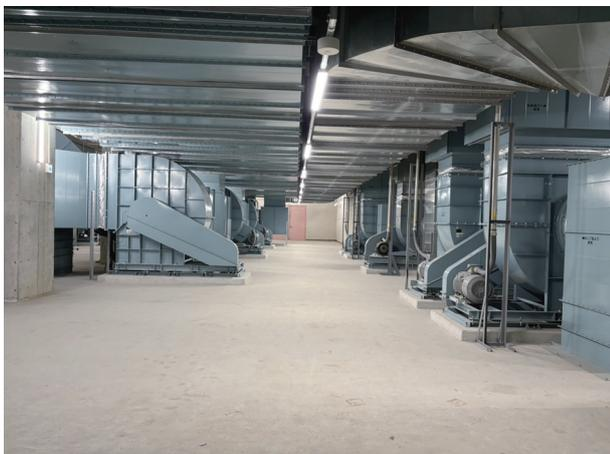
図16 換気機械室写真
