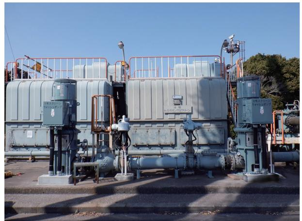
図6 横軸片吸込遠心プロセスポンプ
