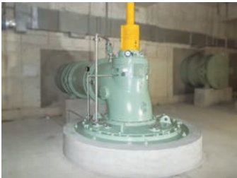
傾き調整機能を備えた立軸ポンプ
