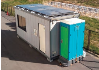
ソーラーパネルを設置した現場事務所
