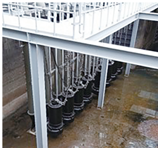
図8 仮設ポンプ設置状況（雨水沈砂池） Fig.8 Temporary pump installation status
