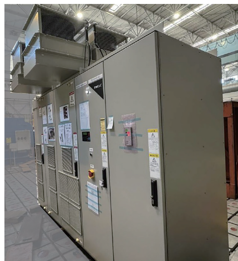
図9 VFD盤外観
