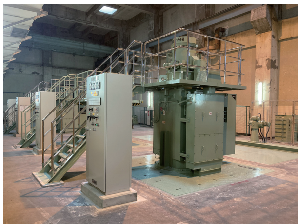
図5 現地据付後の汚水ポンプ4号用電動機
