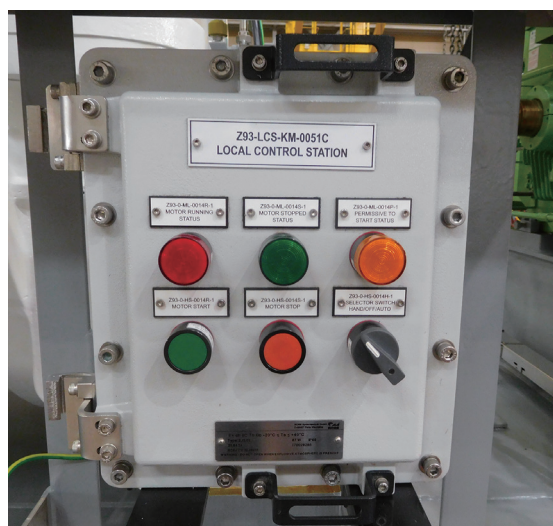
図8 機側操作盤外観
