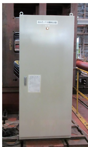
図3 遠隔監視操作盤の外観
