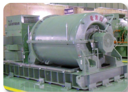
下水処理場 ばっ気用送風機
