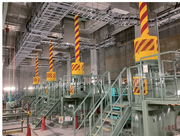
図2 雨水ポンプ室全景
