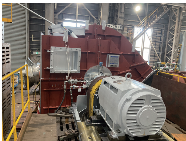
図6 両吸込高効率遠心ファン
