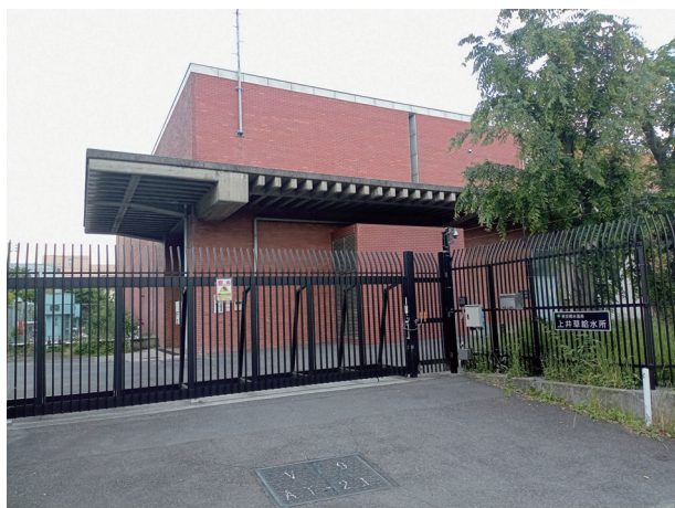
図1 ポンプ室外観
