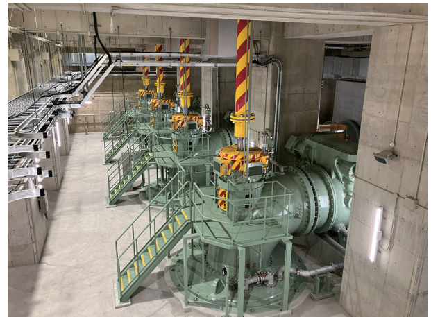
図2 ポンプ室全景
