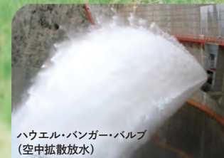
ハウエル・バンガー・バルブ (空中拡散放水)
