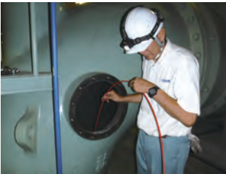
工業用内視鏡カメラを使用した立軸ポンプの内部目視点検
