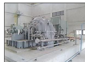
現地製鉄所に納入したガスブロウ
