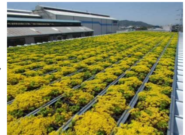
建屋屋上の緑化
