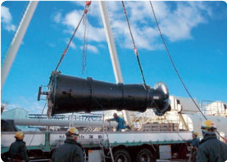
現地据付風景
