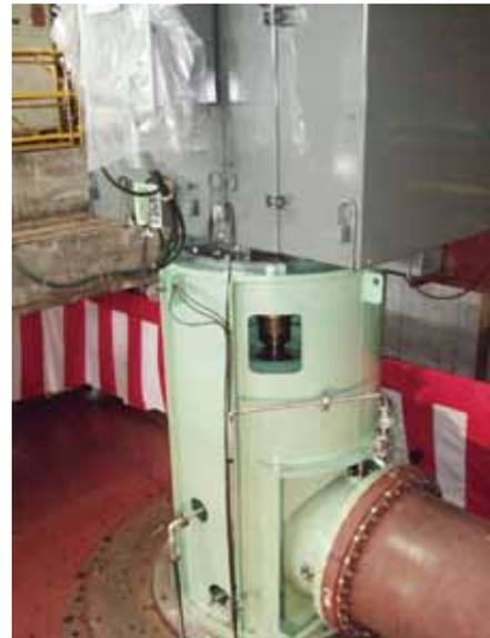
図4 循環水ポンプの運転状況
