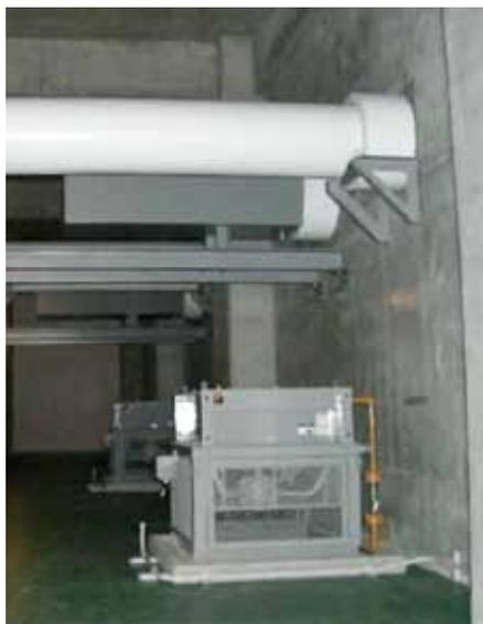
図7 風洞内に設置した空冷式オイルクーラ
