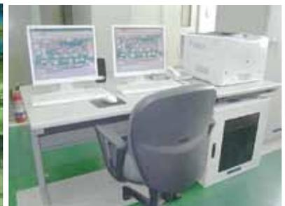
コンピュータモニタ方式監視制御盤
