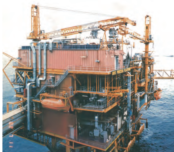
図2 BHSプラットフォーム外観 Fig.2 Outline view of BHS Platform
