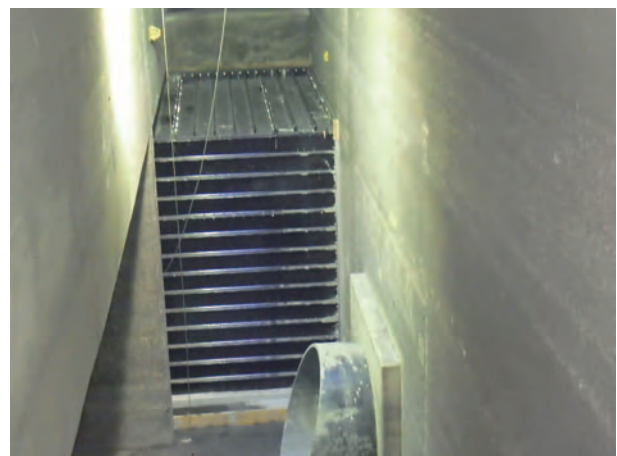
図2 止水箱設置状況
