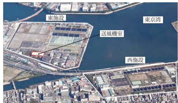
図1 森ヶ崎水再生センターの全景 Fig. 1 Plan view of Morigasaki Water Reclamation
