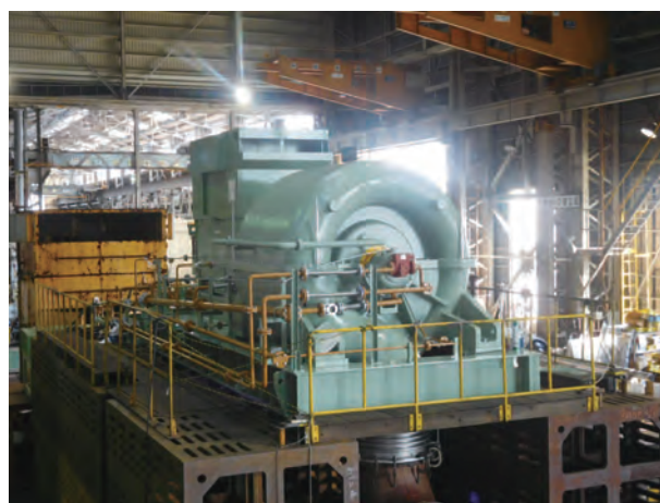
図8 工場試験 Fig.8 Shop test
