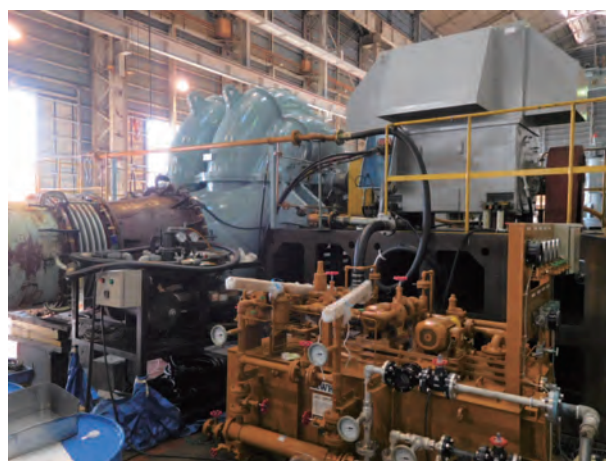
図7 社内試運転 Fig.7 Shop test
