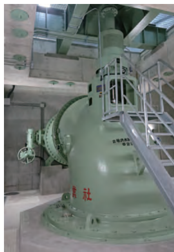
図8 洪水時排水ポンプ据付完了状況
