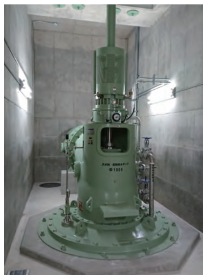
図13 洪水時・常時排水ポンプ据付完了状況 Fig.13 View of the pump after installation
