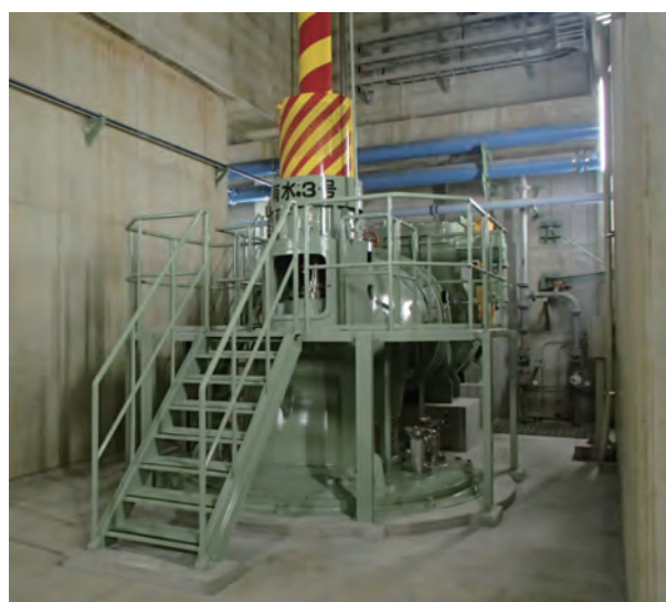
図2 立軸斜流ポンプ
