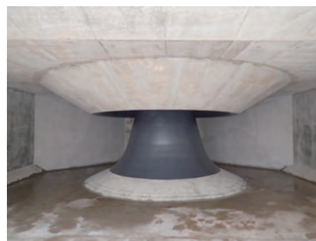
図9 吸込コーンライナ、吸込ベルライナ据付状況
