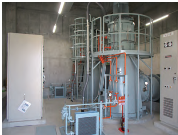
図4 立軸斜流ポンプ
