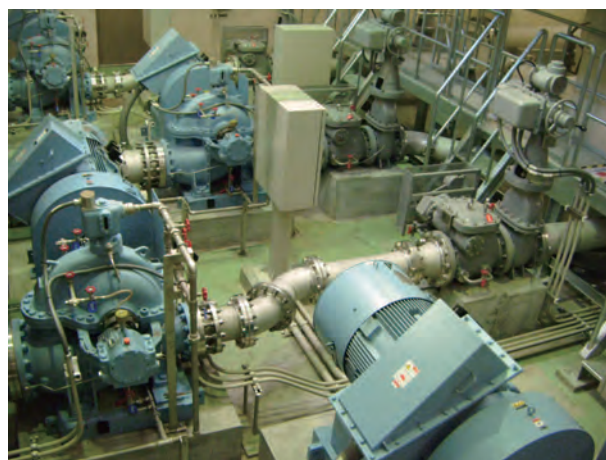
図6 ポンプ室全景
