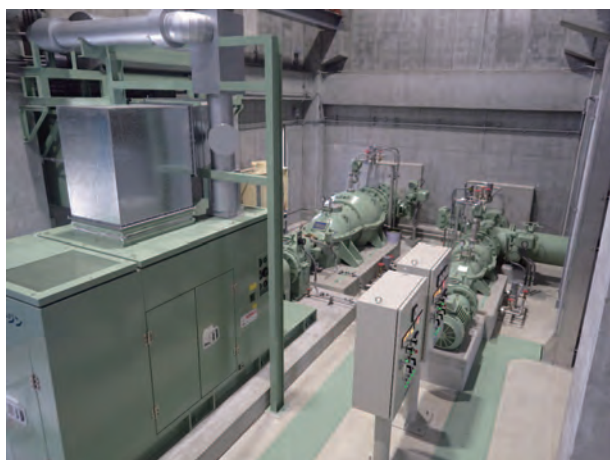
図1 横軸斜流ポンプ
