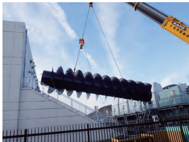
図6 スクリューポンプ据付中
