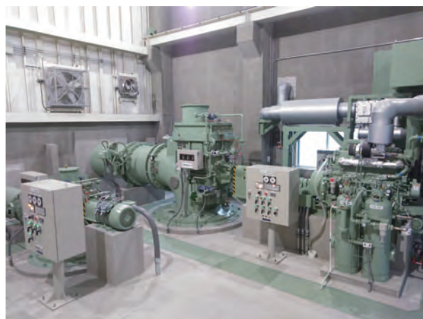
図2 減速機搭載型立軸斜流ポンプ
