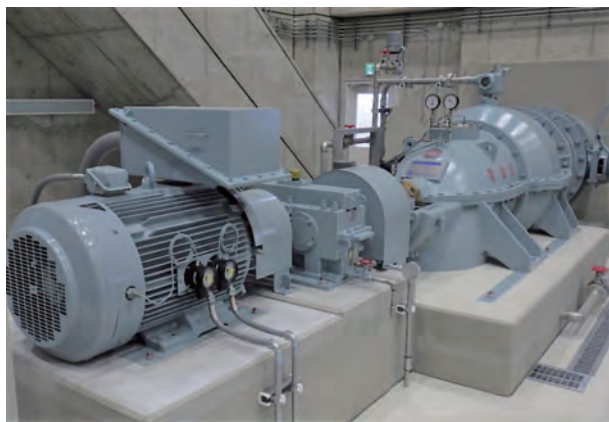
図 6 排水ポンプ据付完成状況
