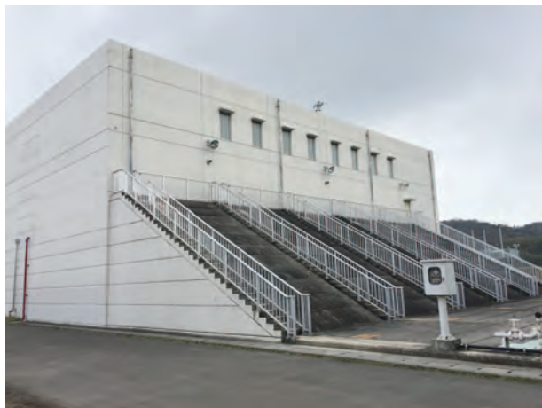
図1 ポンプ場外観
