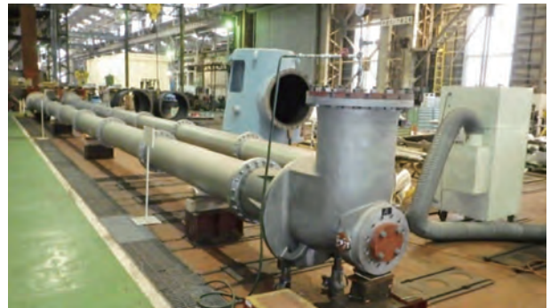
図6 耐圧試験状況
