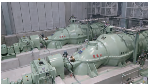
図1 ポンプ室全景
