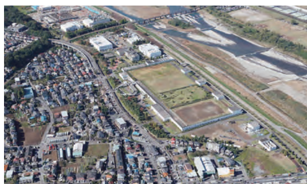
図2 八王子水再生センター全景 (1)
