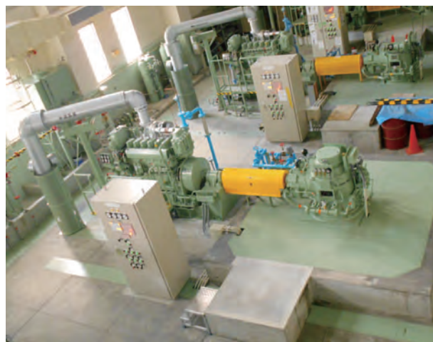
図4 ポンプ室全景
