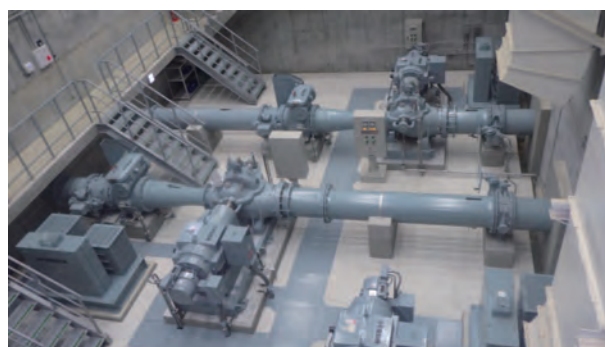
図4 用水ポンプ据付完成状況
