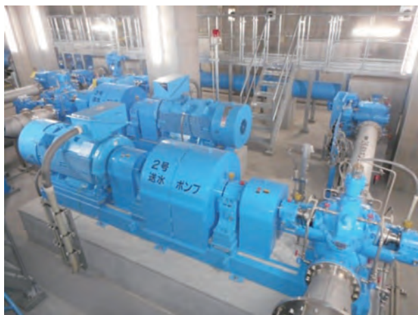
図2 送水ポンプ据付状況
