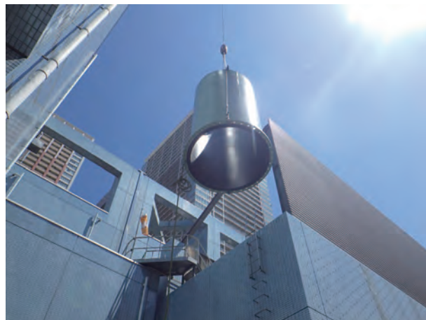
図7 配管の搬入状況
