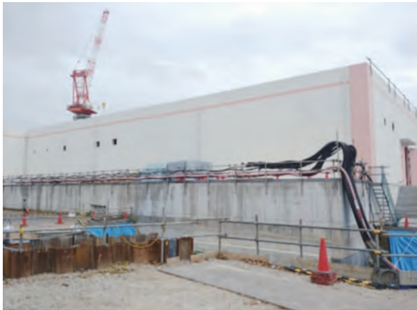
図1 ポンプ場外観 (2021年4月時)
