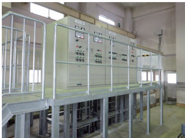
図1 坂本排水機場 配電盤のかさ上げ状況
