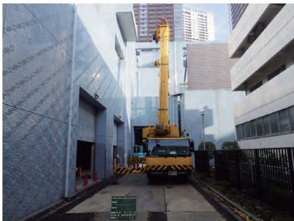
図2 狭小スペースでのクレーン作業状況
