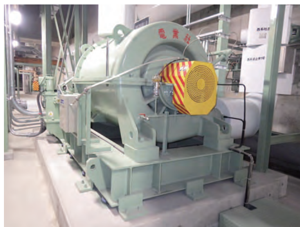
図6 鋳鉄製多段ターボブロワ（ころがり軸受）
