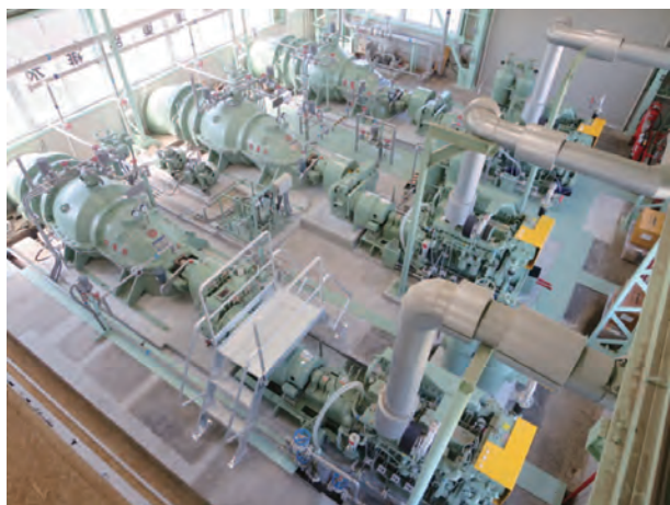
図7 据付完成状況
