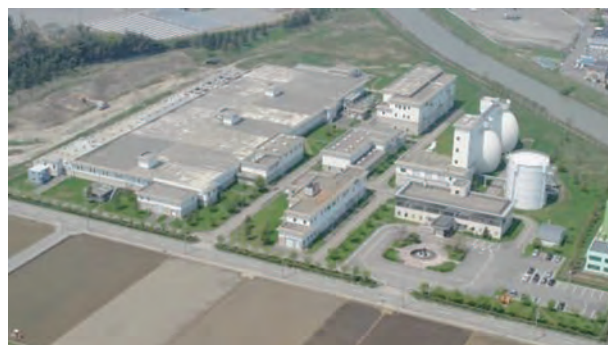
図1 犀川左岸浄化センター全景
