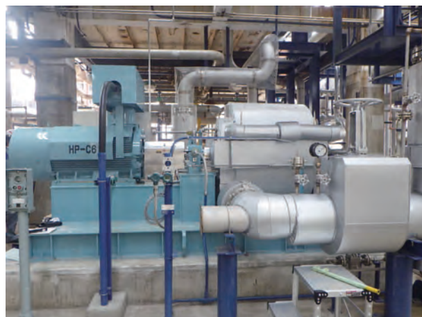
図7 現地据付状態
